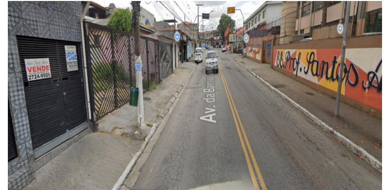
Av. Da Barreira Grande, 795 - Aricanduva
