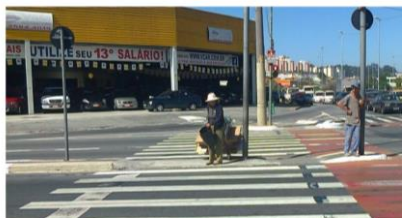
Canteiro Central muito estreito para acomodar pedestres
