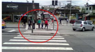
Foto © Local com canteiro estreito, convertido à esquerda e travessia em 2 estôtipos
